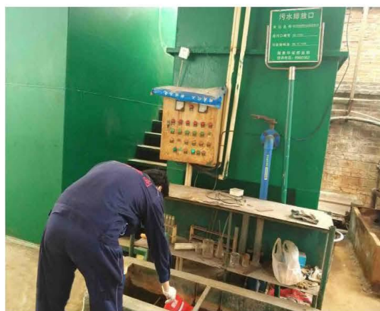
图20: WS-17052 废水排放口 (处理后)
