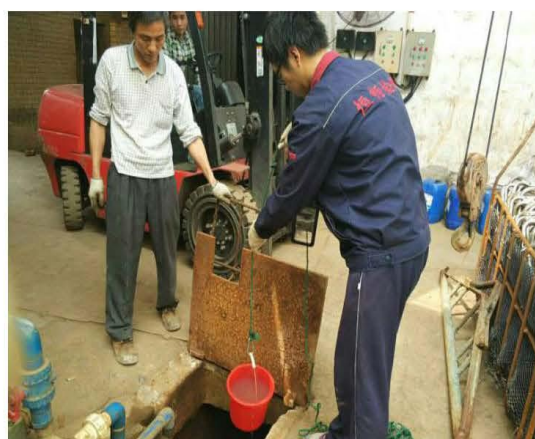
图18: 生产废水集水池（处理前）
