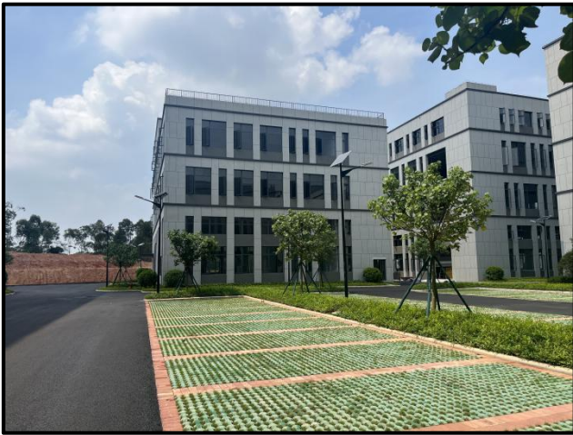
项目西面-空厂房
