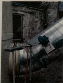
图 5: 焊接工艺废气处理前监测点
